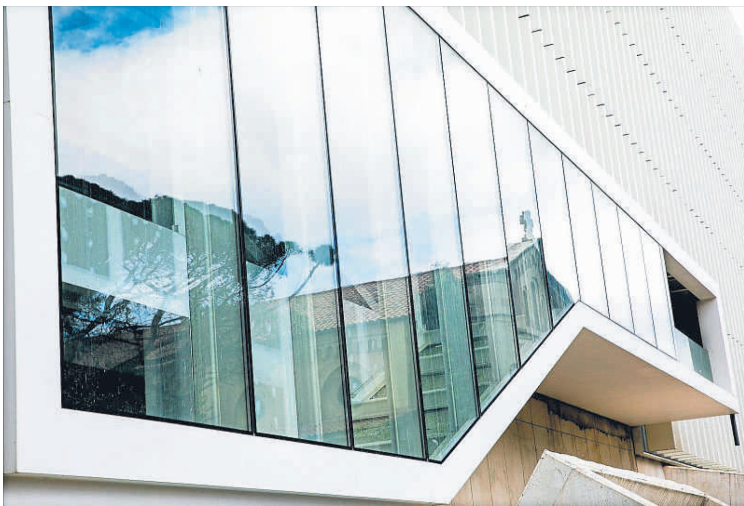
El nou edifici en construcció del BSC, obra de BAAS Arquitectura, té un espai de 700 metres quadrats per a la nova màquina
