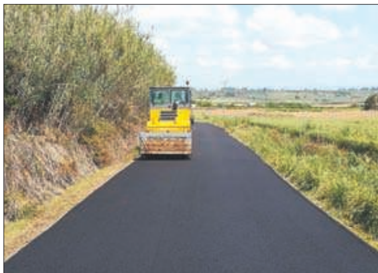
FOTO: Aj. Torrefarrera / El camí ha estat asfaltat per millorar la seguretat
